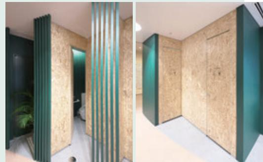
表面材にOSB (Oriented Strand Board) を使用したトイレブース【サニティ TB-TP】
