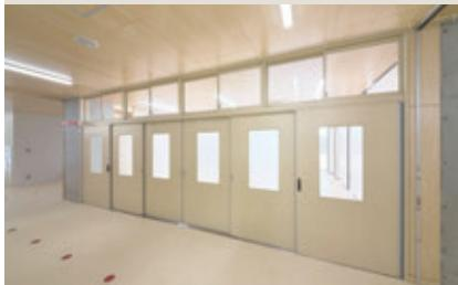
建物付帯工事として溶接により躯体に取付ける間仕切ならびに壁面化粧鋼板パネルの金属工事であります。
